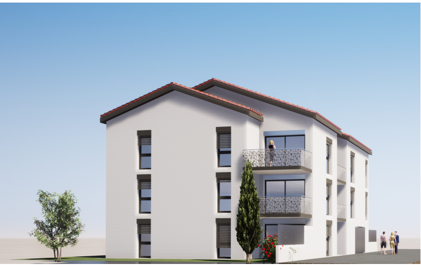
Résidence Chatigny 8 Impasse Chatigny – 69 100 Villeurbanne
